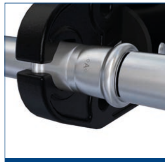
7. Verbindung mithilfe des Presswerkzeugs fertigstellen
