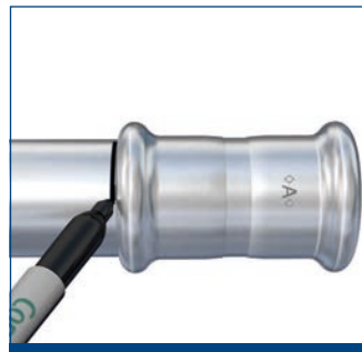
6. Zusammenbauen und die Einstecktiefe markieren
