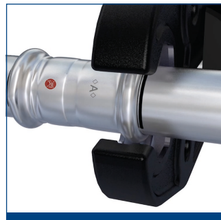
7. Verbindung mithilfe des Presswerkzeugs fertigstellen
