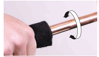
4. Rohrende reinigen
