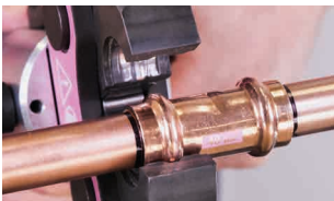
9a. Pressbacke rechtwinklig ansetzen
