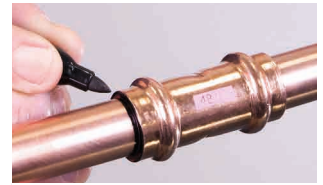
7b. Einstecktiefe markieren (Alternative)
