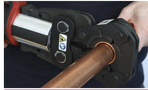
9c. Verpressung durchführen
