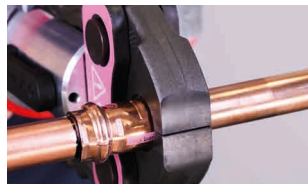
9b. Verpressung durchführen
