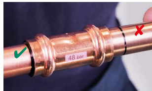
8. Rohr in den Fitting einführen
