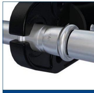
7. Verbindung mithilfe des Presswerkzeugs fertigstellen
