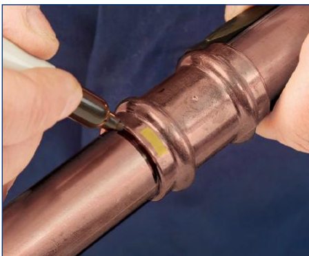
4. Szerelés, beillesztés mélység lelölés
