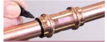
7B. Ou insérez le tuyau jusqu'à la butée et marquez-le
