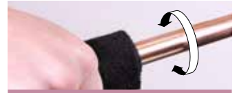
4. Nettoyez l'extrémité du tuyau
