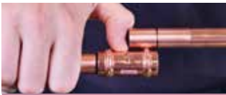
7B. Vérifiez la marque de profondeur
