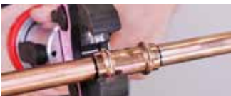
1. Positionnez les mâchoires sur le raccord
