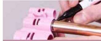
7A. Indiquez la profondeur d'insertion à l'aide d'une jauge de profondeur
