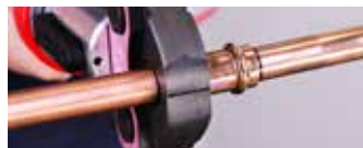
2. Effectuez le sertissage avec l'outil approuvé. Ne sertir qu'une seule fois
