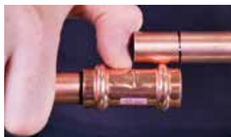
7B. Vérifiez la marque de profondeur
