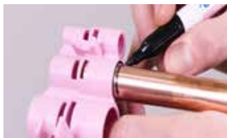
7A. Indiquez la profondeur d'insertion à l'aide d'une jauge de profondeur
