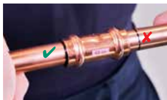
8. Insérez le tuyau dans le raccord. Le tuyau doit être complètement inséré avant d'effectuer le sertissage
