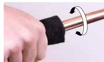
4. Nettoyez l'extrémité du tuyau
