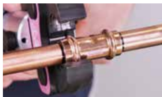
Positionnez les mâchoires sur le raccord
