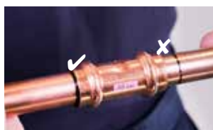
8. Plaats de buis volledig in de fitting. Zorg ervoor dat de buis volledig is ingebracht voordat er wordt geperst
