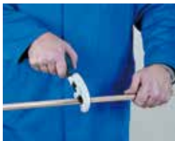
1. Corte de tubo 1. Cortar o tubo
