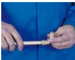
4. Inserción del tubo en el accesorio 4. Encaixar o tubo no acessório
