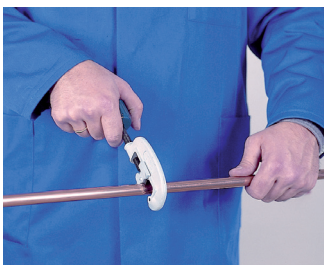
1. Corte de tubo 1. Cortar o tubo
