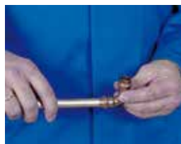
4. Inserción del tubo en el accesorio 4. Encaixar o tubo no acessório
