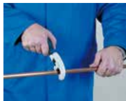
1. Corte de tubo 1. Cortar o tubo
