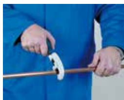
1. Corte de tubo 1. Cortar o tubo
