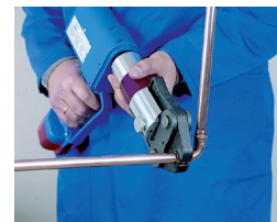
6. Prensado 6. Prensado
