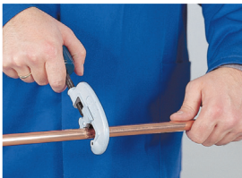
1. Corte de tubo 1. Cortar o tubo
