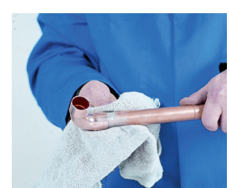
6. Limpieza final 6. Limpeza final
