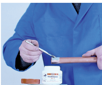
4. Aplicación del decapante 4. Aplicação do decapante
