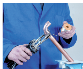
5. Aplicación de la soldadura 5. Aplicação da soldadura
