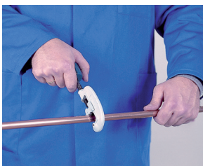
1. Corte de tubo 1. Cortar o tubo
