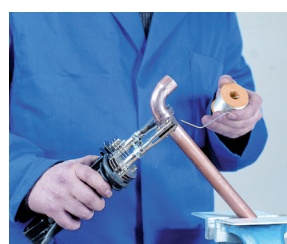
5. Aplicación de la soldadura 5. Aplicação da soldadura
