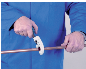
1. Corte de tubo 1. Cortar o tubo
