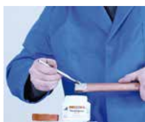
4. Aplicación del decapante 4. Aplicação do decapante
