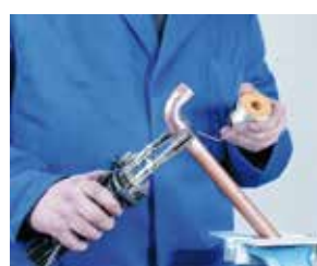
5. Aplicación de la soldadura 5. Aplicação da soldadura
