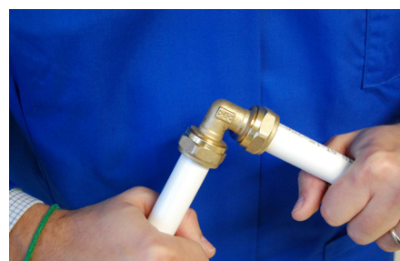
5. Montaje finalizado 5. Montagem terminado
