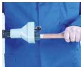
Limpieza exterior del tubo
