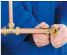
Inserción del tubo en el accesorio
