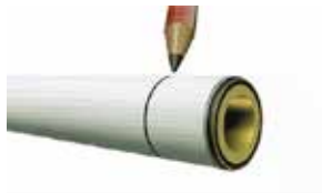
Marcar profundidad de inserción
