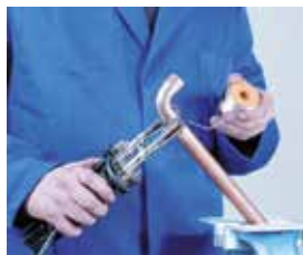
Aplicación de la soldadura fuerte
