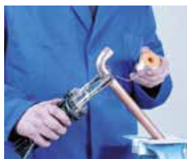
Aplicación de la soldadura fuerte
