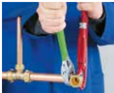
Ajustar la unión mediante una llave inglesa
