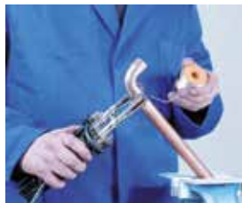
Aplicación de la soldadura fuerte
