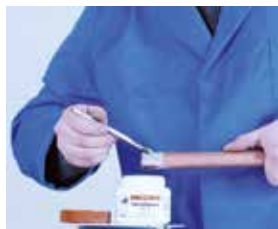
Aplicación del decapante
