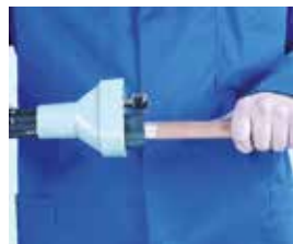
Limpieza exterior del tubo
