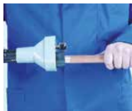
Limpieza exterior del tubo
