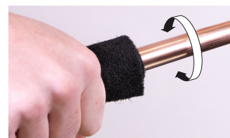
4. Nettoyez l'extrémité du tube
