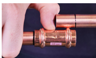
7B. Vérifiez la marque de profondeur
