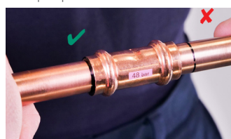
8. Insérez complètement le tube dans le raccord. Assurez-vous que le tube soit complètement inséré avant sertissage
