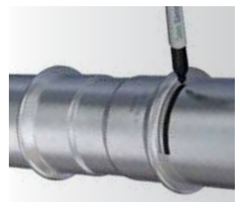
4. Assemblez et marquez la profondeur d'insertion
