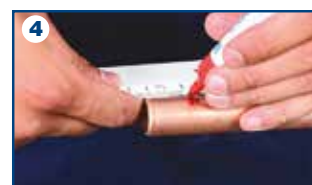
4 Marcatura profondità di giunzione
