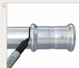
Contrassegnare la profondità di inserimento sul tubo
