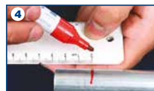
4 Marcatura profondità di giunzione
