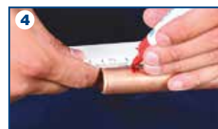
4 Marcatura di profondità
