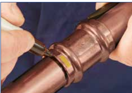
4. Inserire il raccordo e contrassegnare la profondità di inserimento
