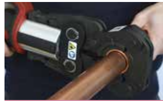
3. Completare la giunzione utilizzando utensili omologati
