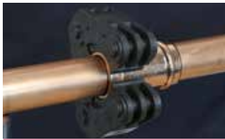
1. Inserire l'anello di pressatura
