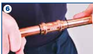
6 Inserire il tubo nel raccordo, sino alla battuta
