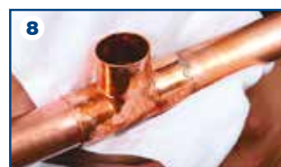
8 Giunzione completata
