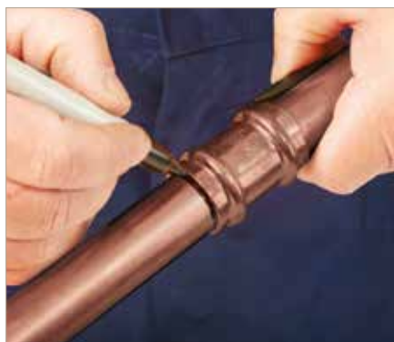
4. Contrassegnare la profondità di inserimento sul tubo tramite il misuratore di profondità
