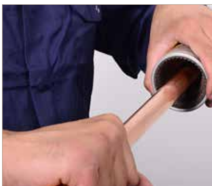
2. Sbavare ed eliminare i bordi taglienti esterni ed interni
