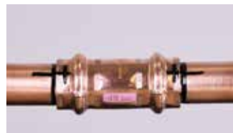
3. Identificazione della giunzione completata
