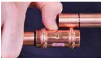
7c. Verifica della profondità di inserimento
