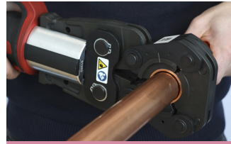
3. Completare la giunzione utilizzando utensili omologati
