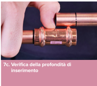
8. Inserire il tubo nel raccordo, assicurandosi che sia completamente in battuta prima di procedere alla pressatura
