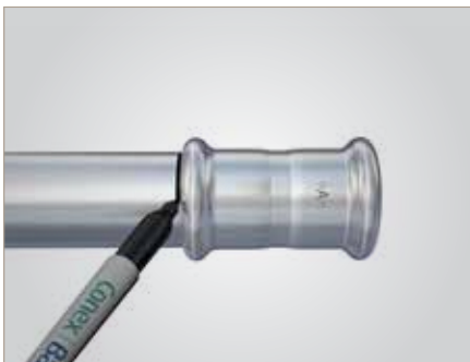
4. Contrassegnare la profondità di inserimento sul tubo
