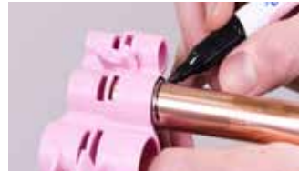
7a. Contrassegnare la profondità di inserimento sul tubo utilizzando l'apposita dima di riscontro
