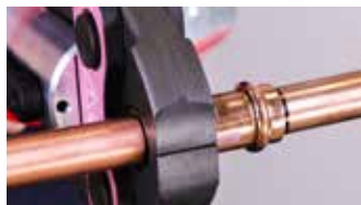
2. Completare la giunzione utilizzando unicamente utensili omologati
