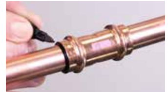
7b. In alternativa, inserire il tubo fino alla battuta e marcare il riferimento
