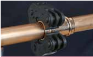
1. Inserire l'anello di pressatura
