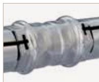
6. Contrassegnare la giunzione completata
