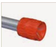
2. Sbavare il tubo esternamente ed internamente
