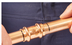
8. A préselés előtt a csövet teljesen be kell helyezni az idomban
