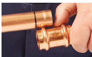
7c. Ellenőrizze a mélység jelölést
