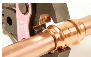
9. A présőfát pontosan illessze az idomra
